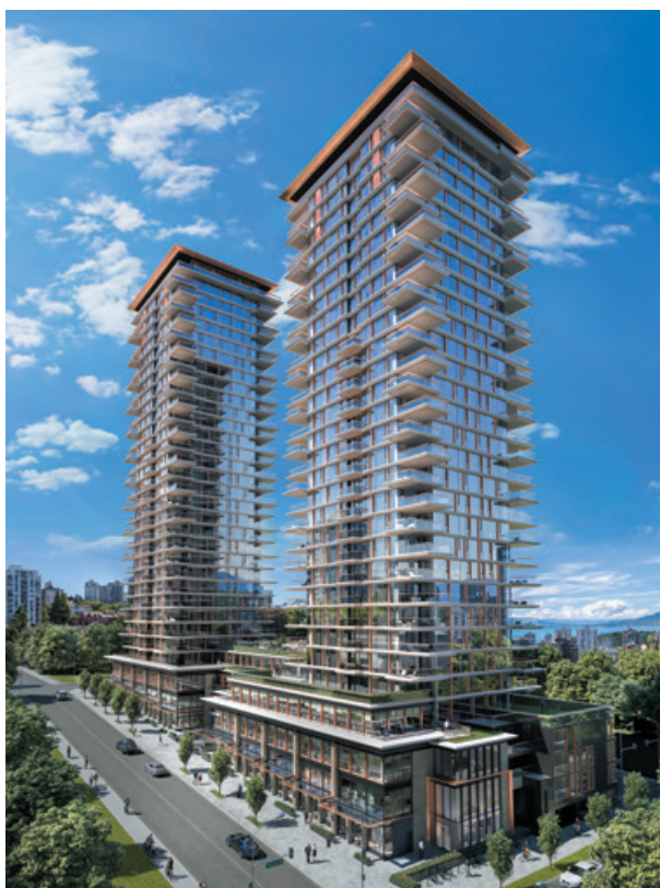
Landmark on Robson：位於溫哥華市中心的住宅發展項目
