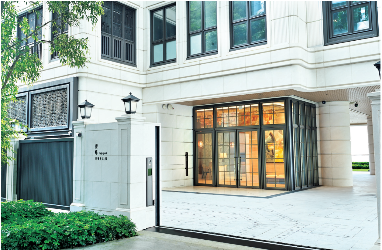
位於寶珊道的「寶峰」住宅發展項目
